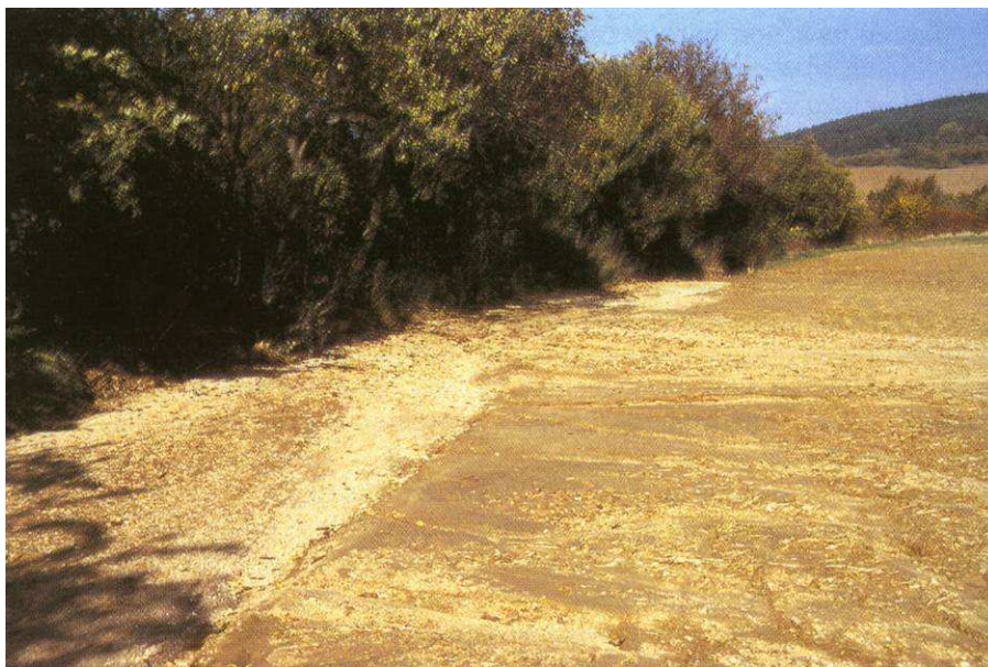
Obr. 12 Protierózna priekopa 150 cm široká a 80 cm hlboká, úplne zanesená eróznymi nánosmi (Fulajtár, Janský, 2005)
