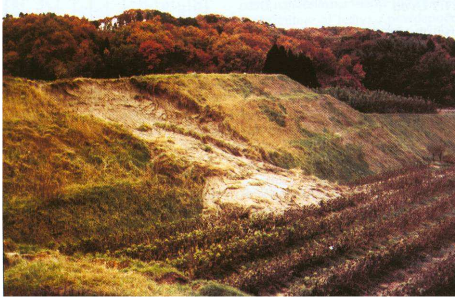
Obr. 14 Zosuv na terasovom stupni rekultivovaného pozemku (Fulajtár, Janský, 2005)
