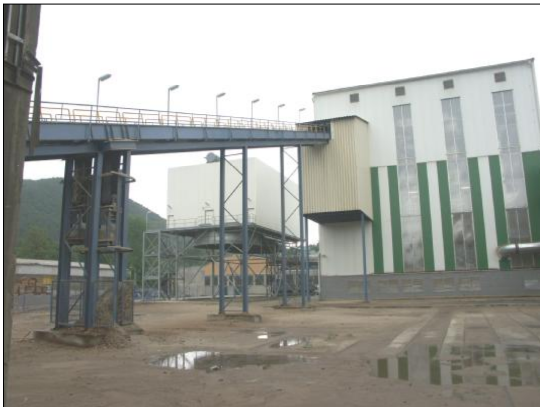
Obr. 20 Hlavný šikmý dopravník biomasy a budova kotolne
