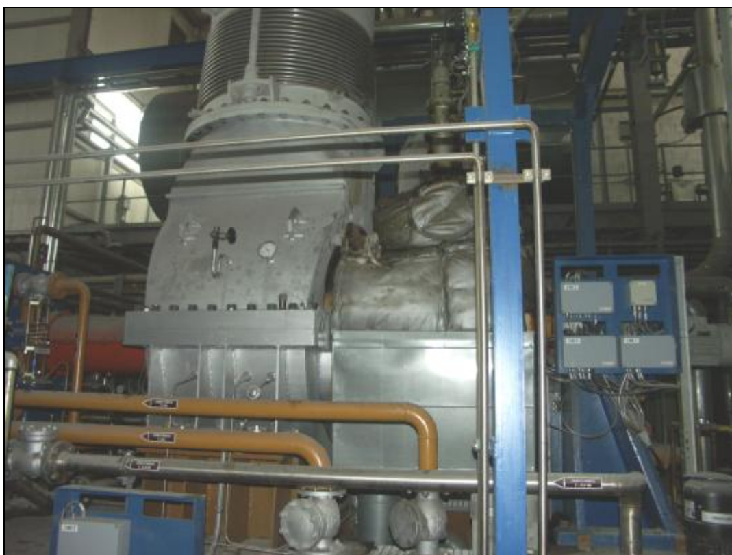
Obr. 25 Kondenzačná turbína s elektrickým generátorom 5,4 MW e
