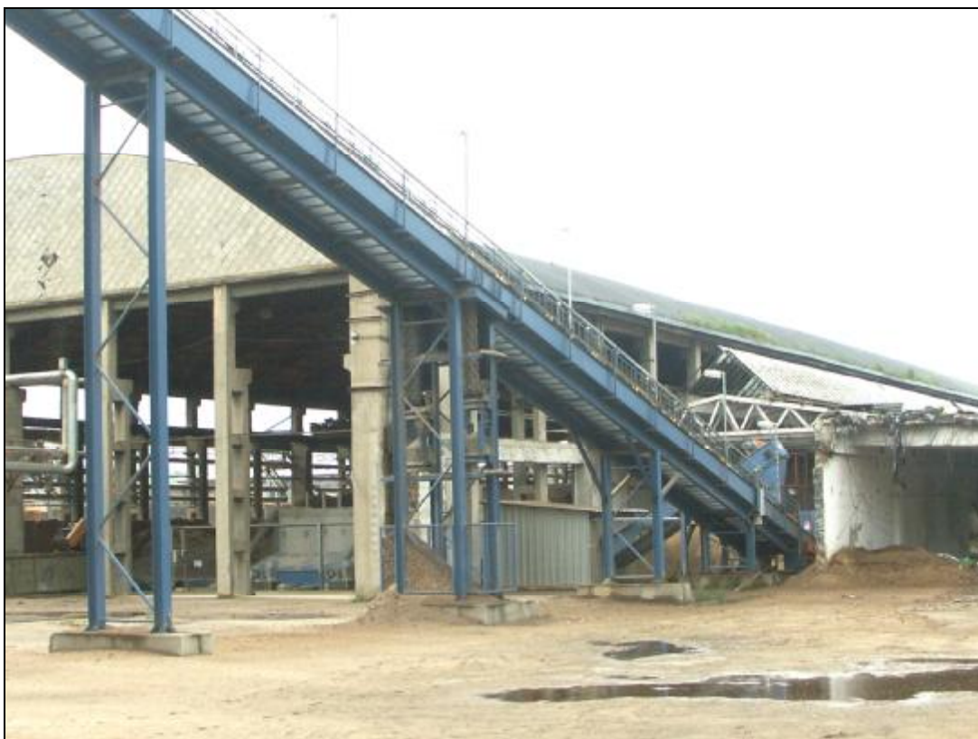
Obr. 21 Operatívny sklad biomasy, triedenie biomasy a hlavný dopravník biomasy
