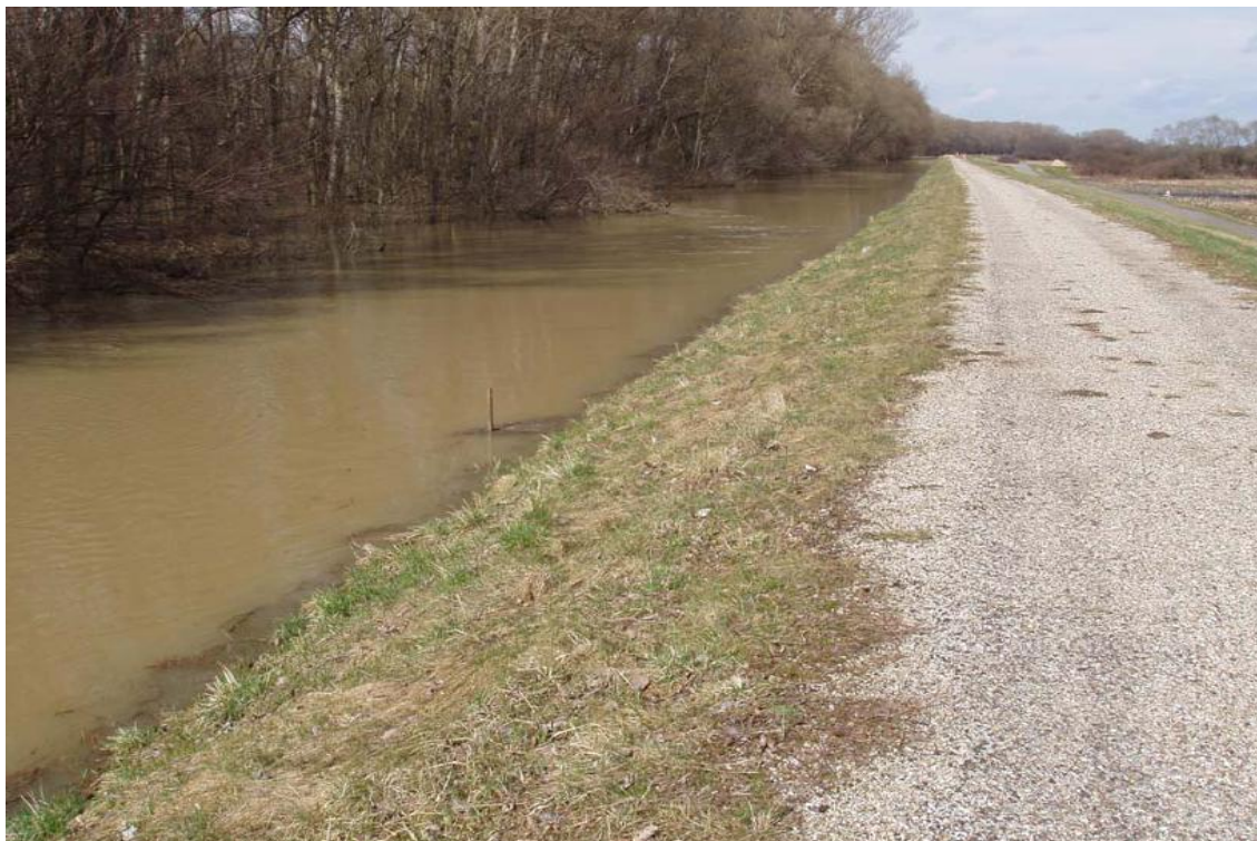
Obr. 3 Stúpanie hladiny vody
