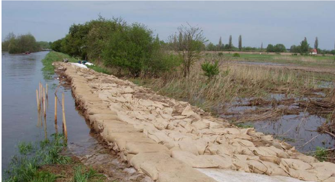
Obr. 7 Nebezpečie vylitia vody
