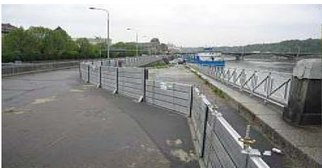
Obr. 10 Oceľové protipovodňové bariéry
