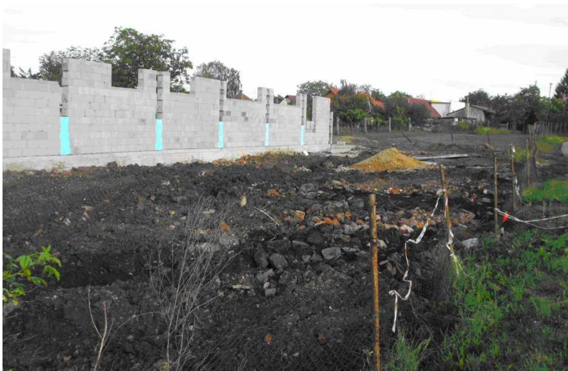
Foto 7.2 Pohľad na násyp parkoviska.
