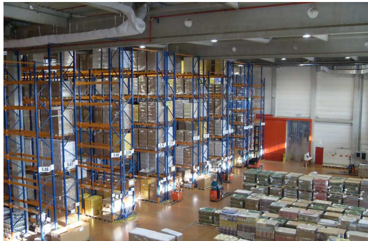
Obr. 6 Pohľad na skladovacu halu H5
