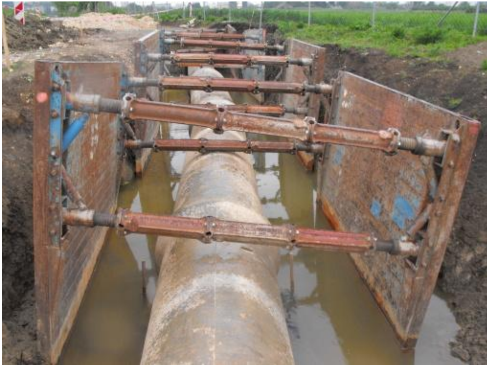
Obr. č. 8: Paženie pri výkopoch (foto: Konc, 2010)
