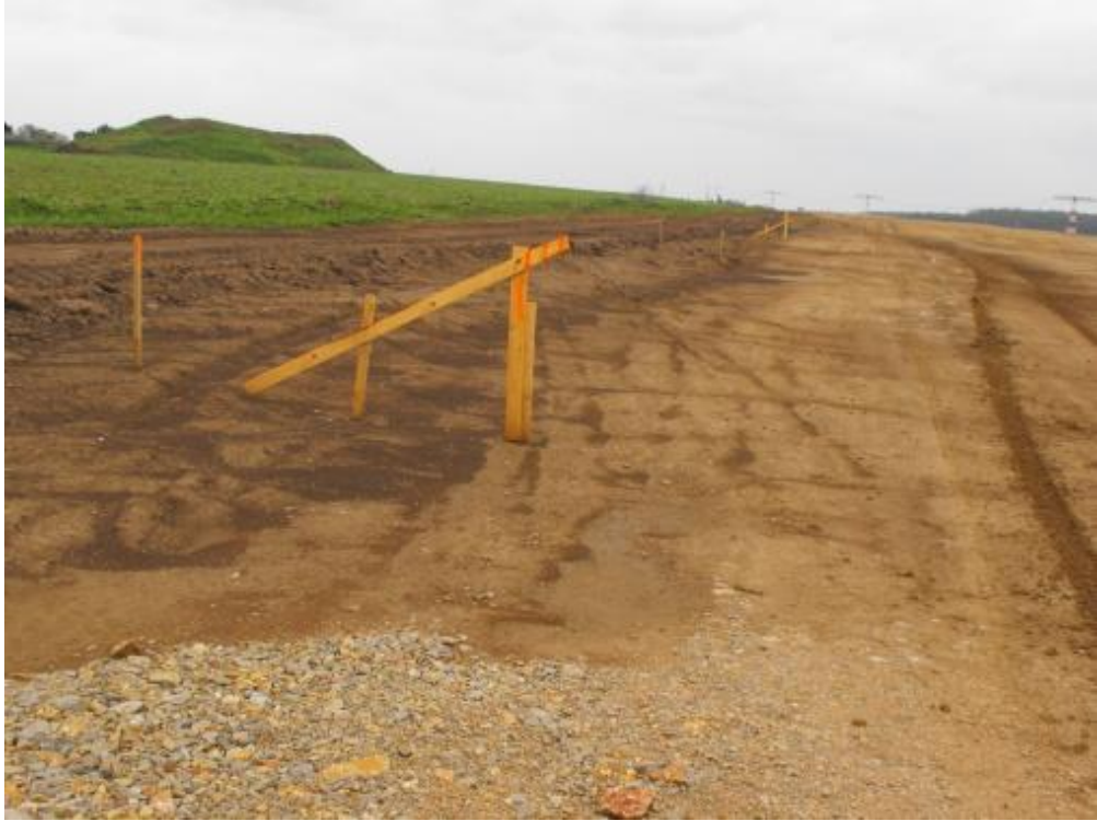
Príloha č. 3 : Ukážka vytýčenia latového profilu (násyp) I. (foto: Konc, 2010 )
