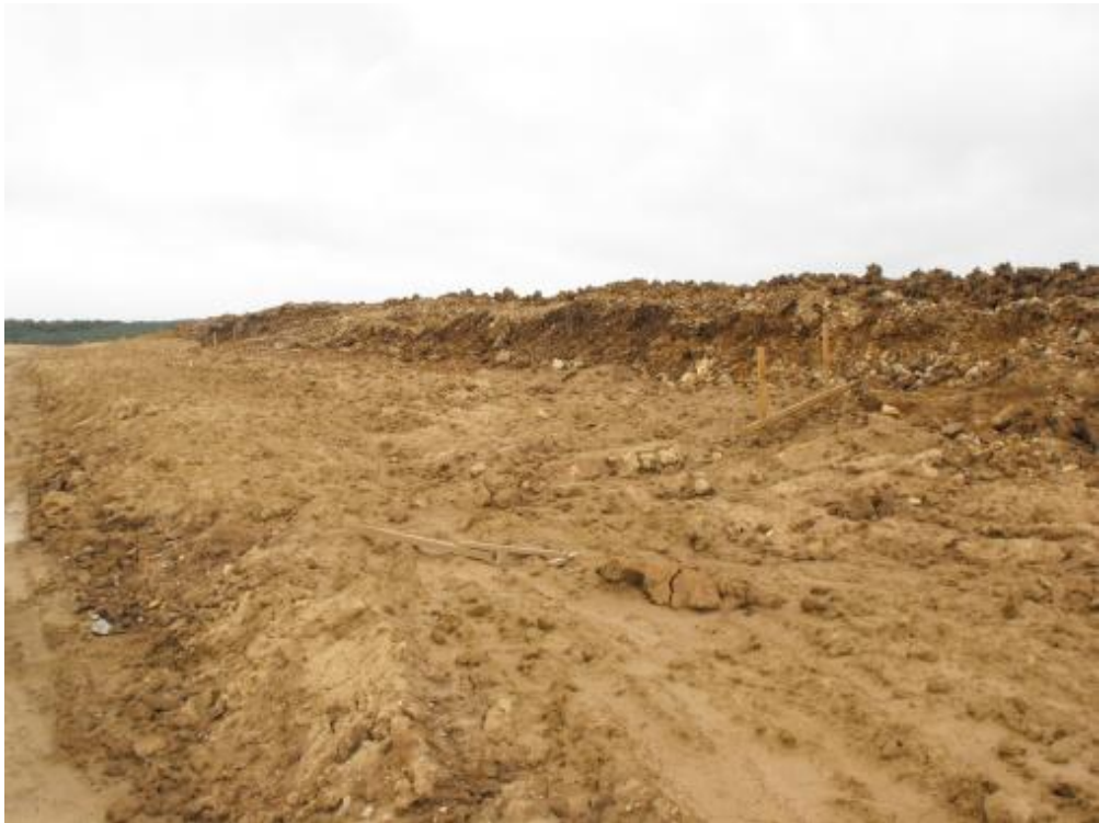
Príloha č. 2 : Ukážka vytýčenia latového profilu (výkop) (foto: Konc, 2010 )
