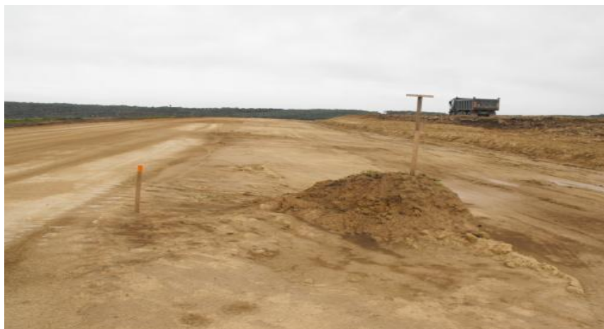
Obr. č. 3: Vytýčenie cestnej komunikácie (foto: Konc, 2010)
