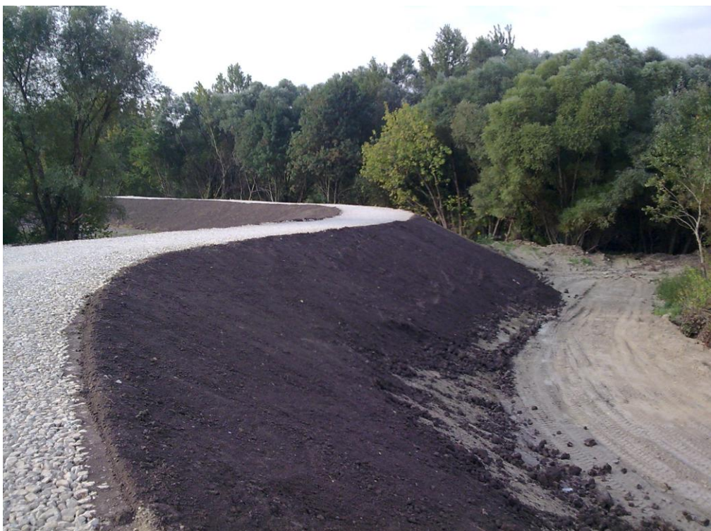
Príloha č.6 : Zahumusovanie násypového svahu komunikácie (foto: Konc, 2010 )
