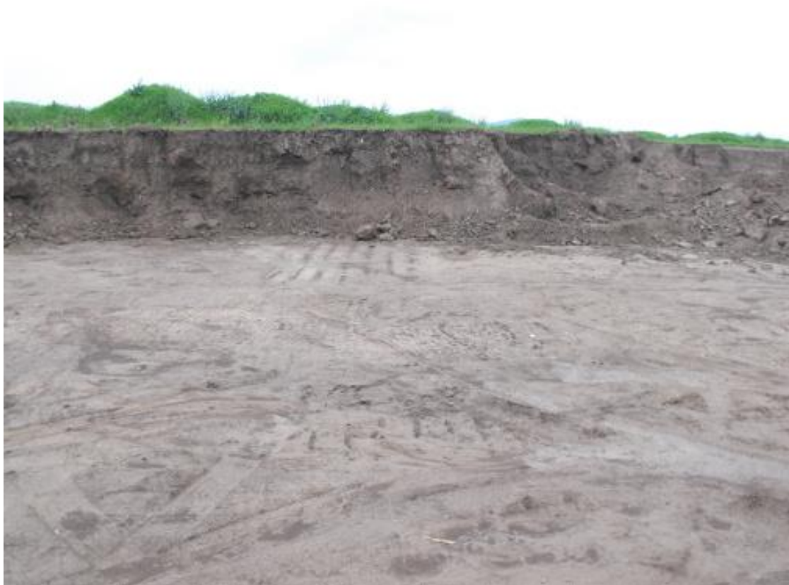
Obr. č. 5: Depónia vyťaženej ornice (foto: Konc, 2010)
