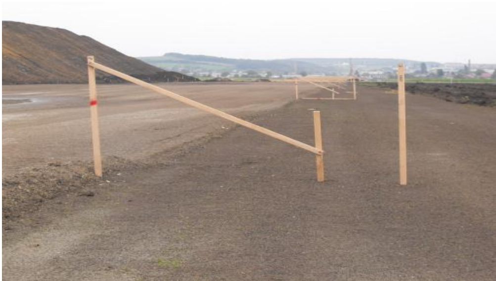
Príloha č. 4: Ukážka vytýčenia latového profilu (násyp) II. (foto: Konc, 2010 )
