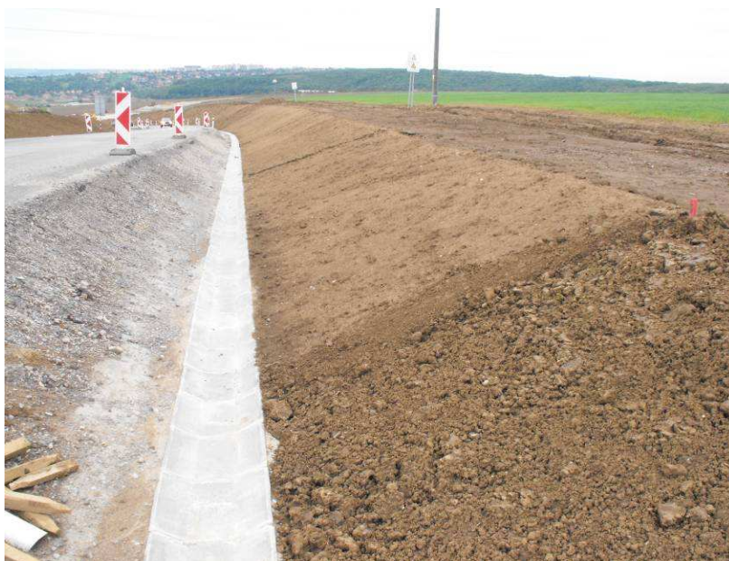
Obr. 10 Pozdĺžna odvodňovacia priekopa cesty (foto: Konc, 2010)
