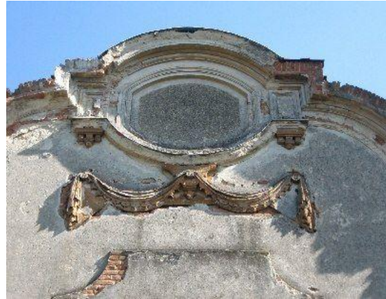
Obr.: Detail severnej fasády
