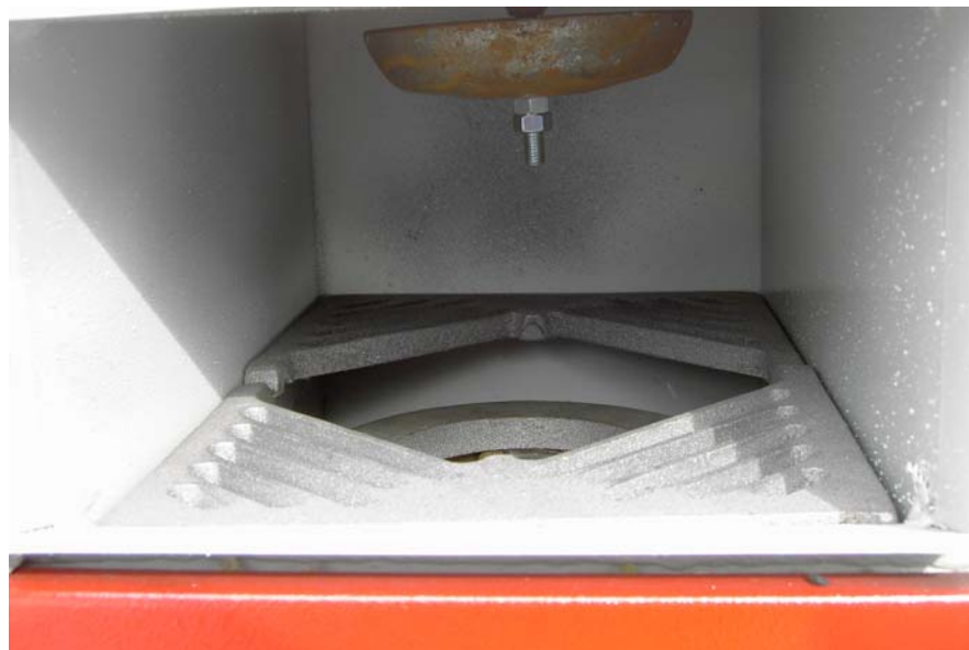
Obrázok 30 Detail spaľovacieho priestoru v kotle (foto autor)
