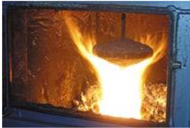
Obrázok 30 Detail spaľovanie peliet v kotle (pelety zo zmesi čistých pilín č. 5) ( www.kotlylokca.sk )
