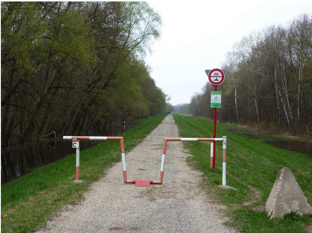
Obr. 7. Zabezpečenie koruny hrádze bezpečnostnou závorou (Ježek, 2010)
