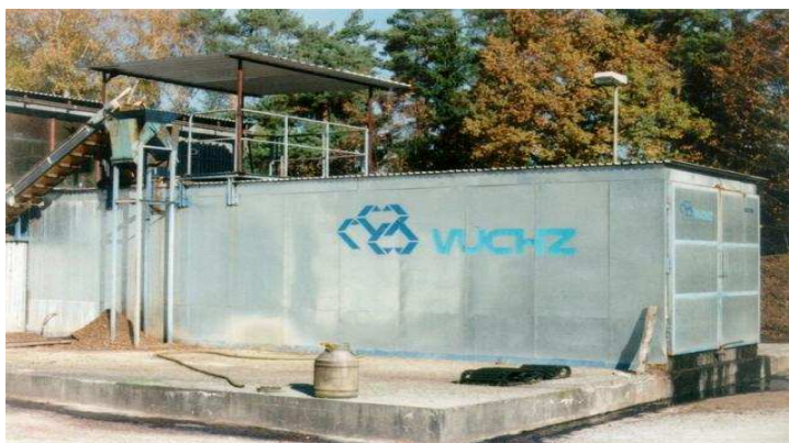
Obr. 22 Kontinuálny (tunelový) kompostovací reaktor – Nová Paka (ČR) (Galovič, 2007)
