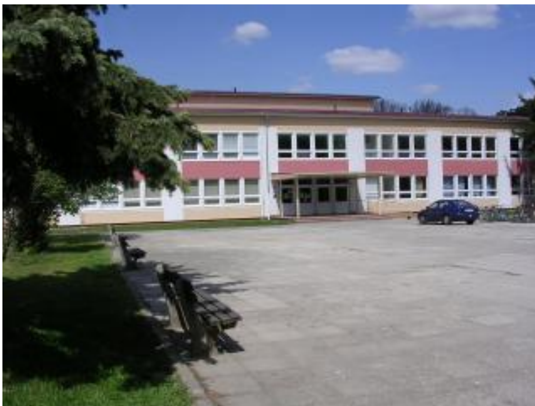
Obr.č.2 Základná škola
