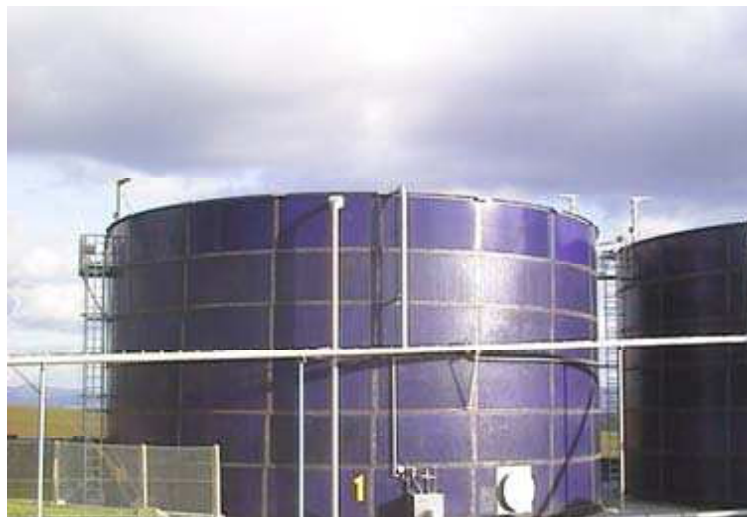
Obr. 4 Nadzemná skladovacia nádrž na hnojovicu
