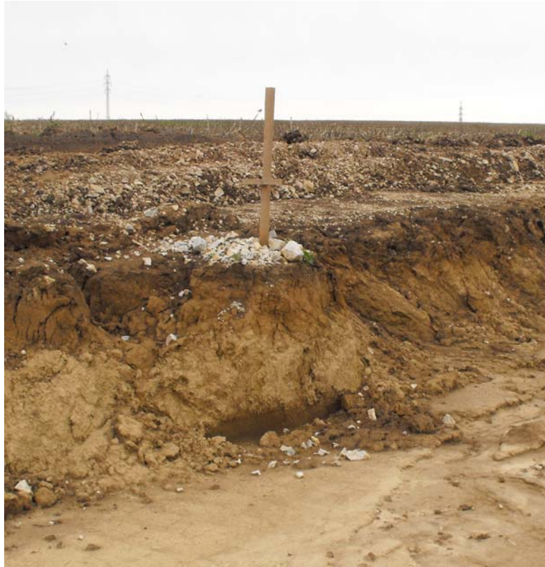
Obrázok 7.3 Latový profil pre vytýčenie hĺbky výkopu
