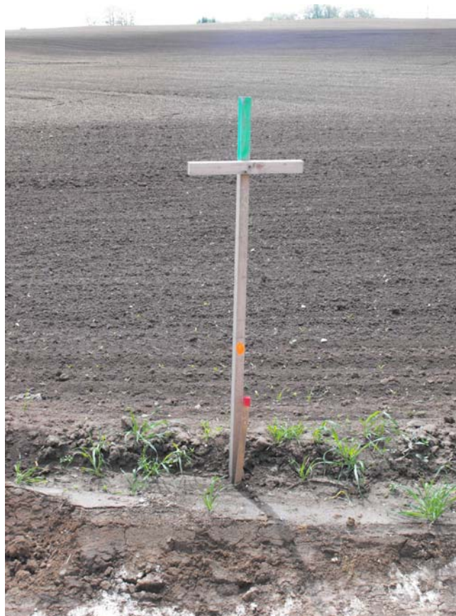
Obrázok 7.1 Vytýčenie výšky bodu PBP pomocou terénneho kolíka a výškovej laty
