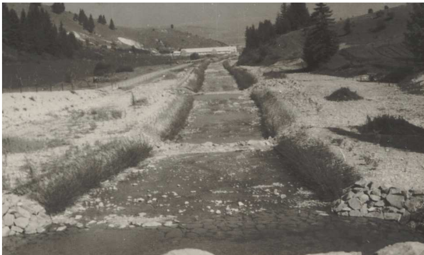
Obrázok č. 10: Spevnené koryto bystriny Ilánovka
