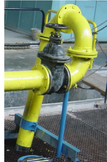
Obrázok 29 Detail na miesta odberu tlaku pred a za zvarom pomocou špeciálneho kovového prípravku (vľavo), ručne ovládaný ventil používaný na regulovanie prietoku; zavzdušňovacie koleno (vpravo)
