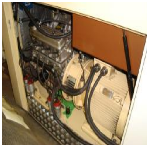
Obr.23 Kogeneračná jednotka s elektrickým výkonom 22 kW a tepelný výkonom 42 kW v Kolíňanoch
