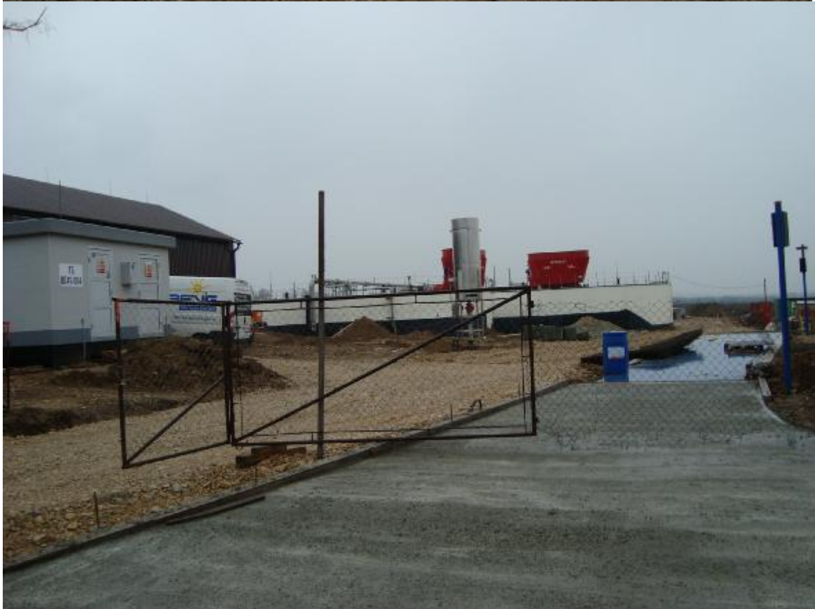
Obr.24 Výstavba bioplynovej stanice s elektrickým výkonom 1 MW a tepelným výkonom 2 MW v obci Malý Cetín
