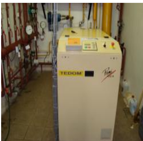
Obr.23 Kogeneračná jednotka s elektrickým výkonom 22 kW a tepelný výkonom 42 kW v Kolíňanoch
