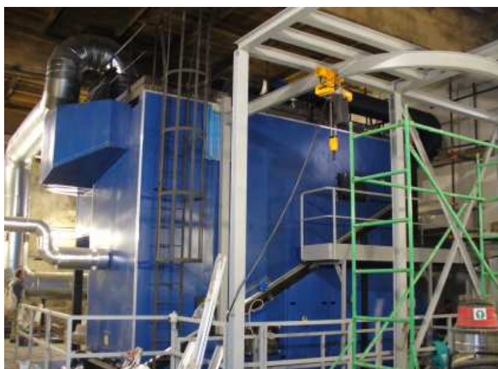
Obr. 22 Inštalácia kotla VESKO-B
