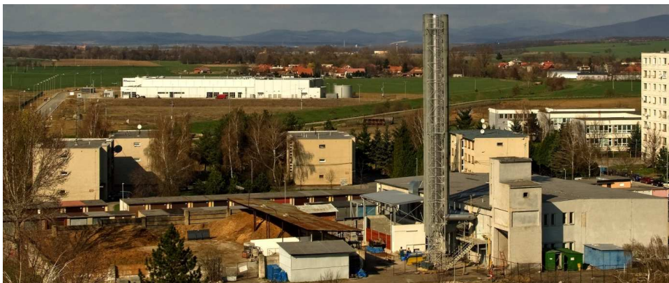
Obr. 21 Pohľad na kotolňu CK Lúky a skládku drevnej štiepky
