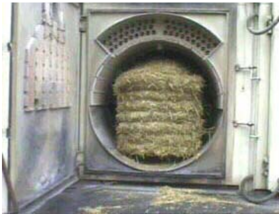
Obr. 11 Pohľad do spaľovacieho priestoru kotla na veľké valcovité balíky
