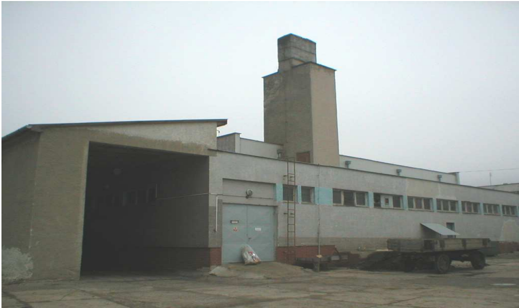
Kotelňa pred rekonštrukciou
