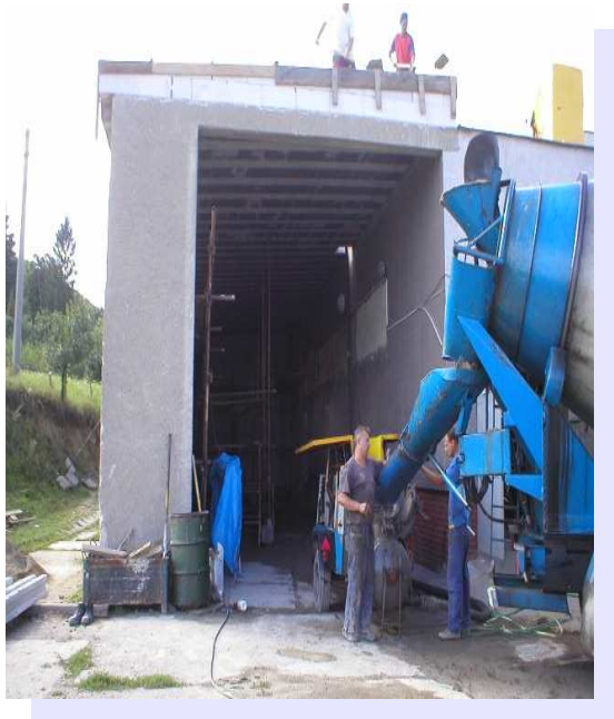
Rekonštrukcia uhoľne a sklad slamy
