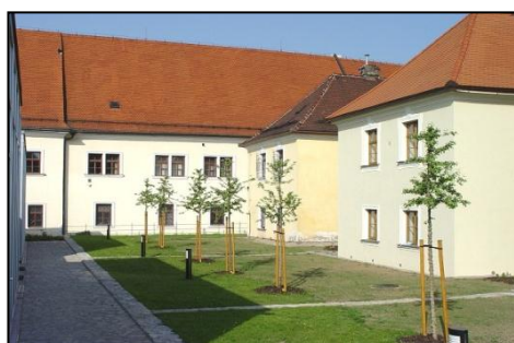
Obr.43 Po rekonštrukcii komplexu z roku 2002
