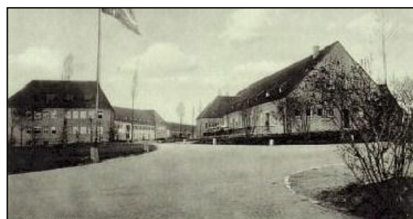
Obr.27 Bývalé kasárne v Kitzingene
