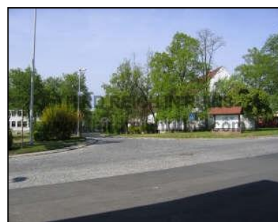
Obr.28 Bývalé kasárne v Kitzingene
