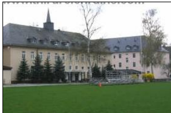
Obr.30 Ústredie kasární v Bambrgu
