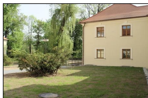
Obr.44 Po rekonštrukcii komplexu z roku 2002
