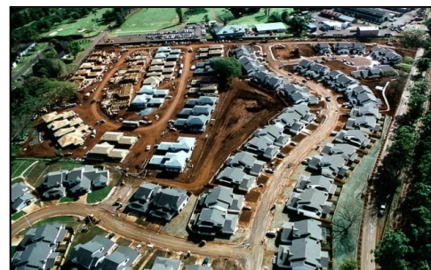
Obr.7 Detail kasární Schofield
