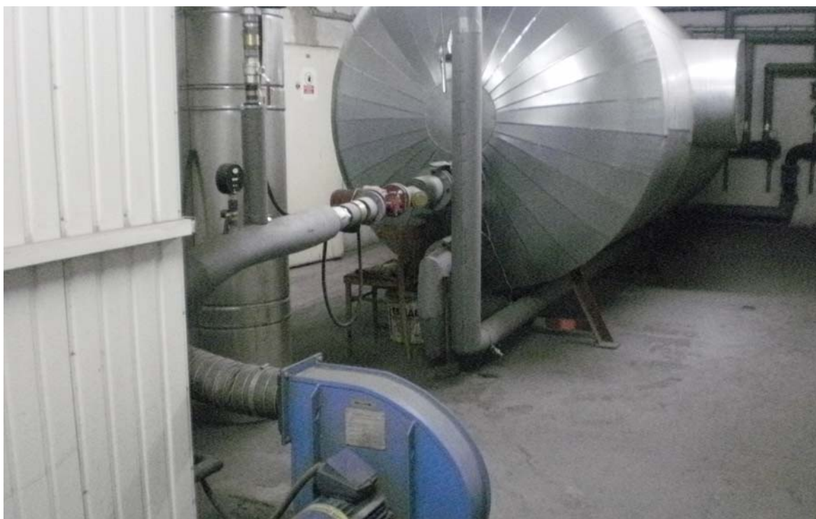
Obr. 11 Kotolňa na spaľovanie slamy
