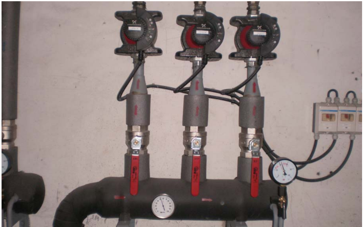
Obr. 12 Samostatné vykurovacie okruhy
