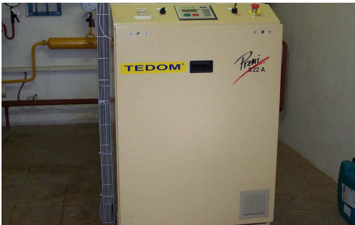
Obr. 23 Kogeneračná jednotka Premi S22 A
