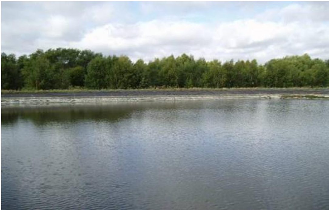
Obr.2.5.2 Zásobníková nádrž odpadových vôd v Enköpingu ( www.biom.cz )
