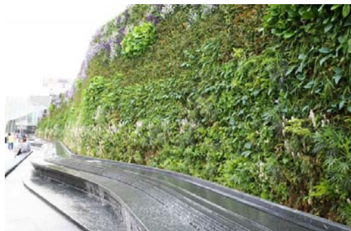
Obr. 4.1.4 Pohľad na živú stenu s vodným prvkom
