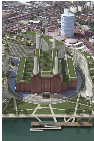
Obr. 4.2.2 Rekonštrukcia elektrárne Battersea Power Station
