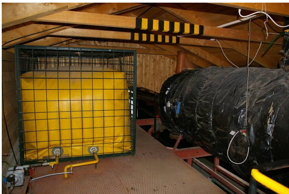
Obr.21 Experimentálny fermentor s plynojedom.
