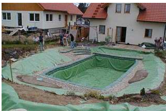
Obr. 17, Aplikácia substrátu
