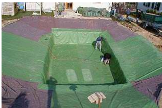
Obr. 15, Pokladanie hydroizolácie
