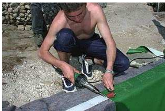
Obr. 16, Zváranie fólie
