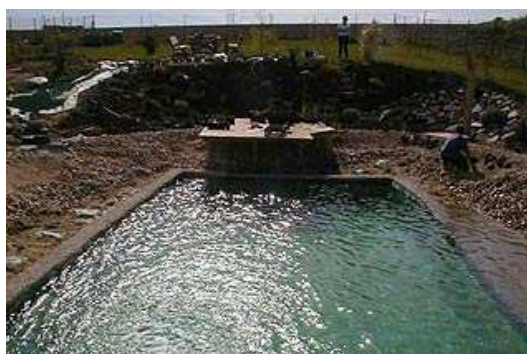
Obr. 18, Napúšťanie biobazéna
