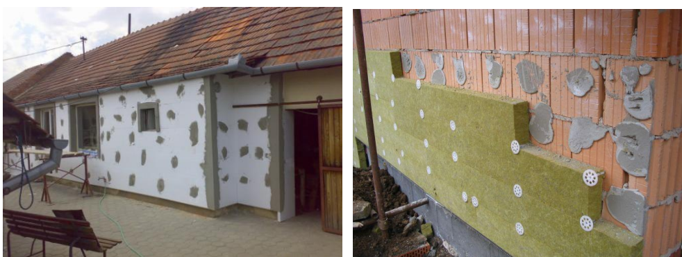
Obrázky 03 a 04: Ukážka zateplenia RD pomocou polystyrénu (03) a minerálnej vlny (04)
