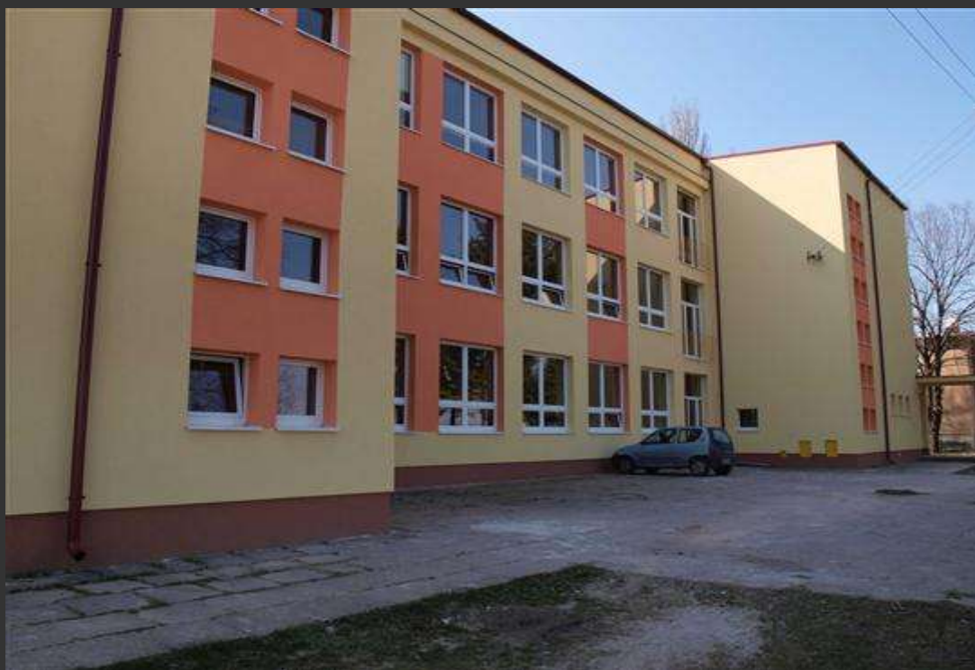
Obr. č. 7 Základná škola
