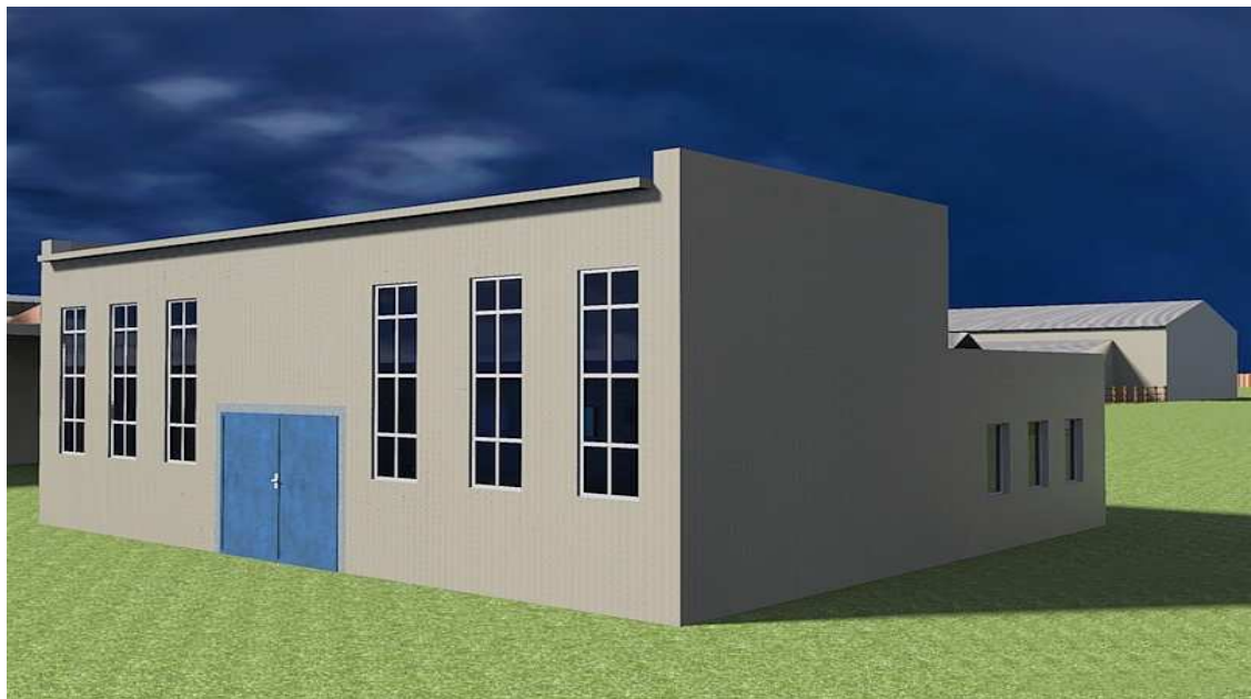
Obr. 37 Širokohlý pohľad na Hospodársku budovu č.7
