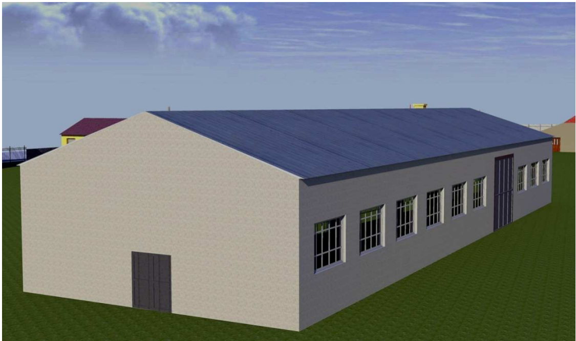
Obr. 29 Širokohlý pohľad na Miešiareň krmív
