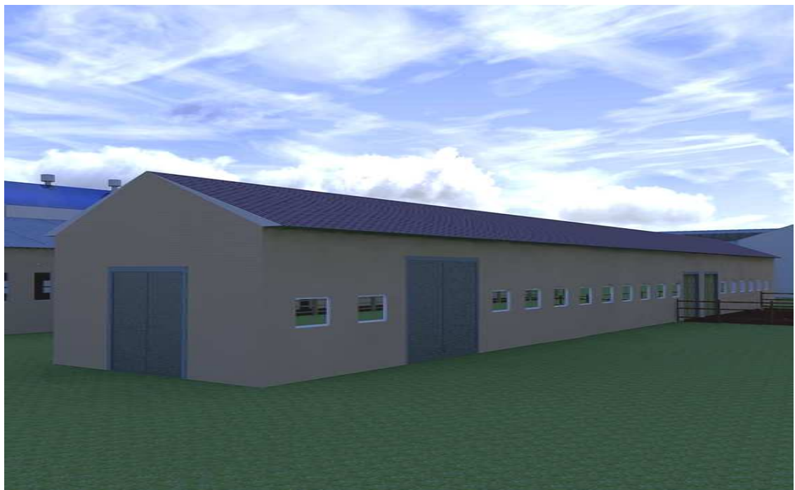
Obr. 34 Širokohlý pohľad na Hospodársku budovu č.4
