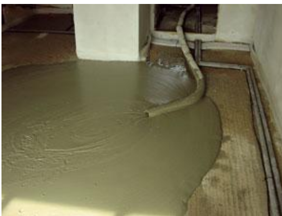
Obr. 12 Distribúcia a aplikácia penobetónu hadicou
