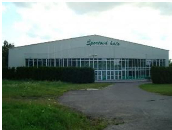
Obr. 13 Spádová strecha, športová hala v Leviciach
