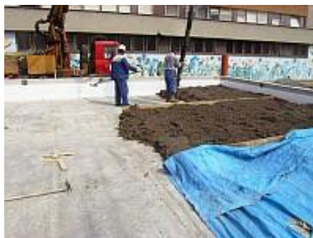
Obr. 15 Betonáž materskej školy
