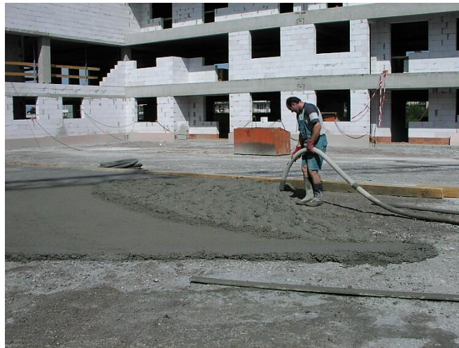
Obr. 14 Vytváranie spádovej vrstvy plochej strechy
