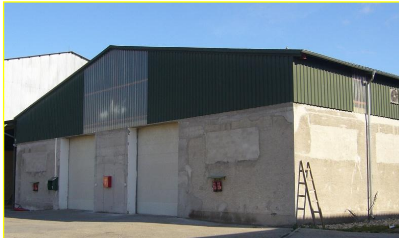
Obr. 21 Skladové priestory po rekonštrukcii.
