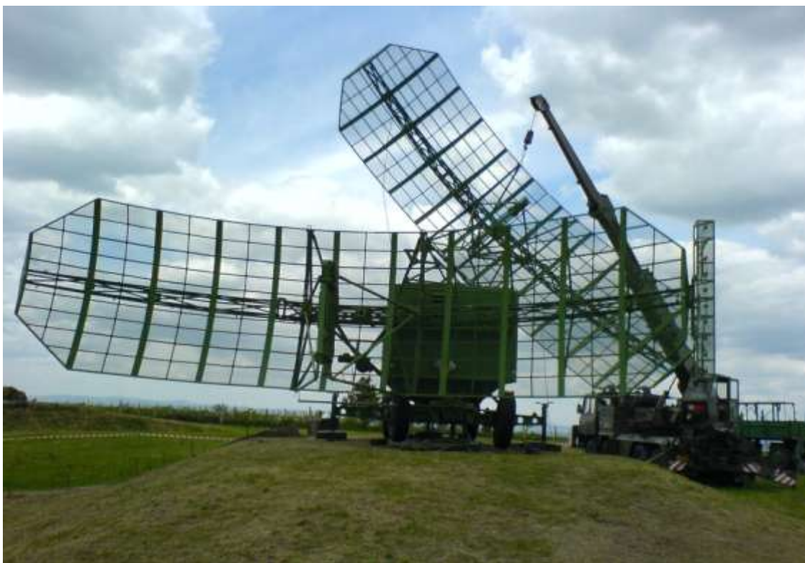
Obr. 2 [Montovanie horného reflektora. Rádiolokátor P – 37MSK] (14)
