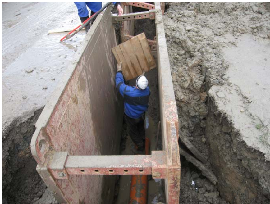
Obr. 9.1 Paženie výkopu a uloženie potrubia
