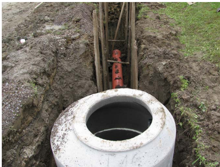
Obr. 9.3 Prepojenie kanalizačného potrubia a šachty
