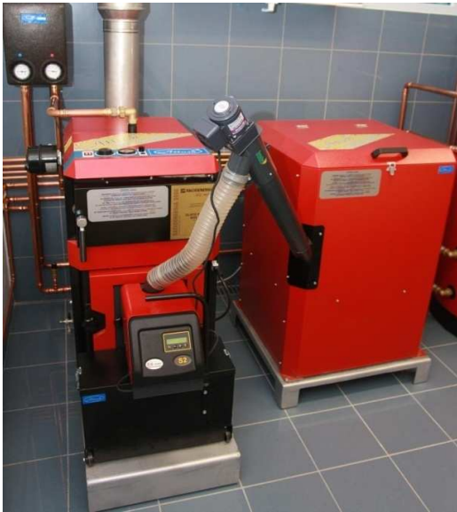
Obr. č. 18 - Kotel ATTACK PELLET 30 Automatic ( ATTACK s.r.o)
