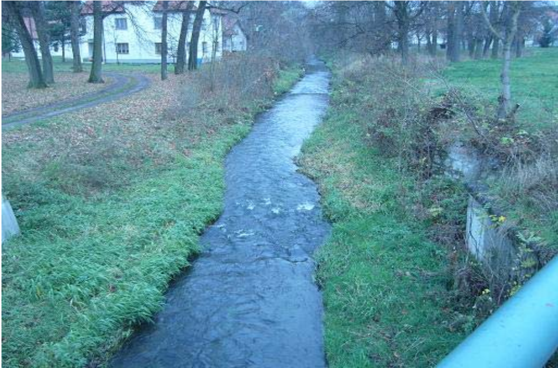
Príloha č. 1 Drahožica v riešenom úseku
