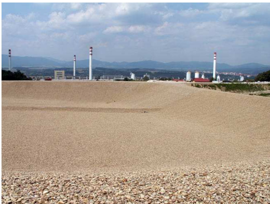
Obrázok 17 Výstavba kazety K3 na nebezpečný odpad
