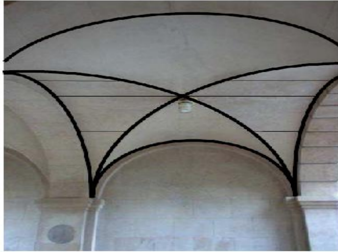
Obr.17 Křížová klenba z vyznačenými tvoriacimi krivkami
