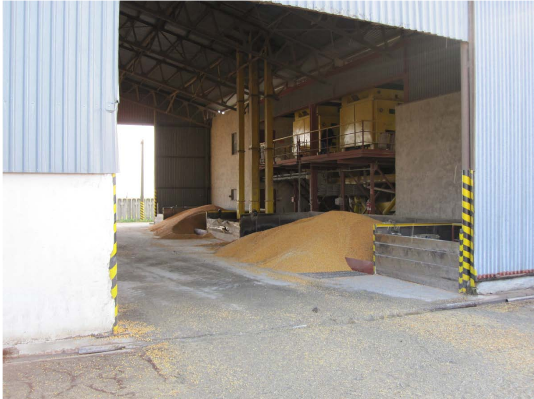
Obr. 17: Budova s čističkami Petkus
