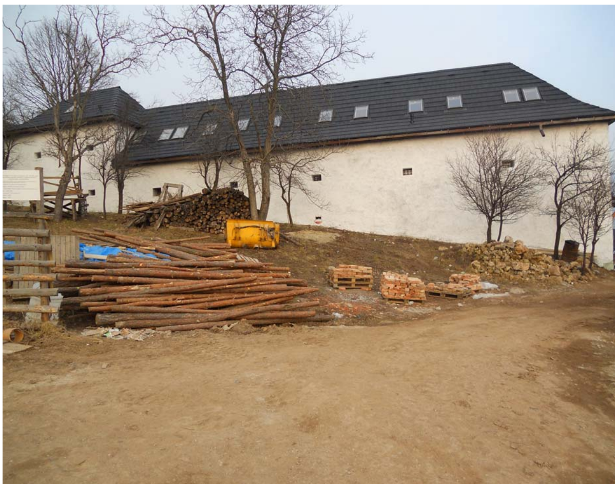
Obr. 2 Sýpka v Jablonove nad Turňou počas prebiehajúcej rekonštrukcie. Foto: Bc. Atila Kardos
