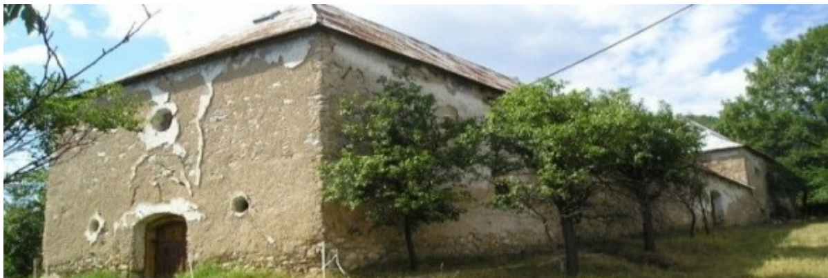
Obr. 1 Sýpka v Jablonove nad Turňou pred rekonštrukciou. Zdroj: Portál Alma centrum, 2010
