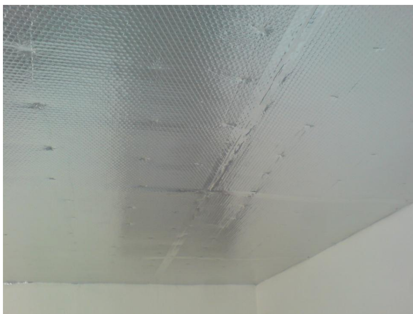
Obr.6 Paronepriepustná fólia s odrazovým pôsobením tepla až 95%.
