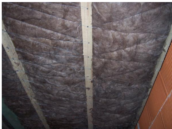
Obr. 7 Realizácia stropu s minerálnou vlnou hrúbka 200 mm.
