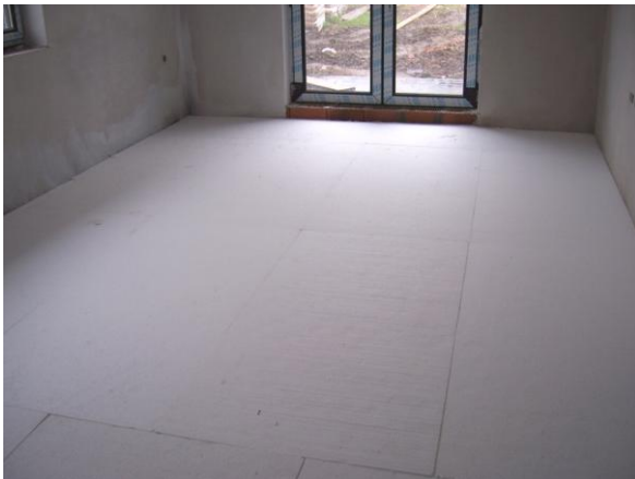
Obr. 9 Uloženie tepelnej izolácie podlahy prekladaním.
