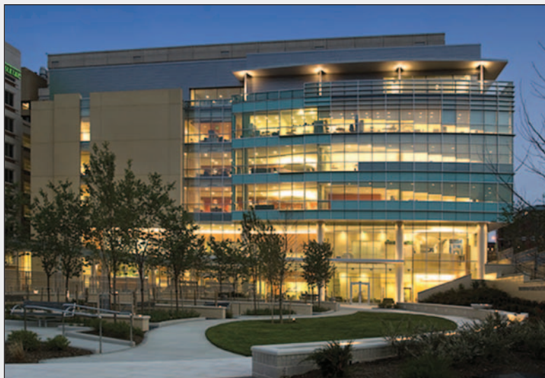
Obr. č.10 Areál a budova nemocnice
