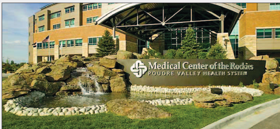
Obr. č.4 Pohľad na vstupnú časť nemocnice
