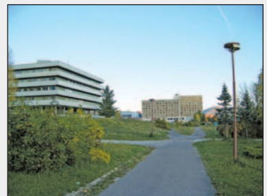
Obr. č. 22 Zlý stav komunikácií a osvetlenia v južnej časti areálu
