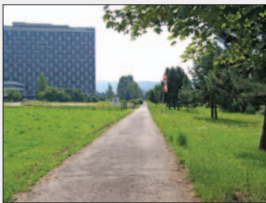
Obr. č.29 Budova lôžkovej časti a heliport
