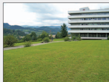
Obr. č.28 Pohľad na budovu detskej fakultnej nemocnice a priestranstvo pred ňou
