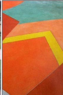
Obr.č.9: Detail dlažby(Zdroj č. 1)
