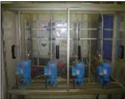
Obr. 3 Dávkovacie čerpadlá koncentrátov (PP-VÚ-04, 2010)
