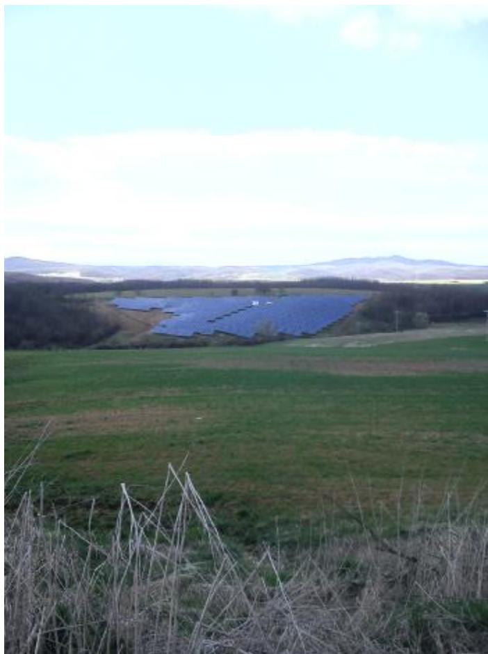
Príloha č. 5: FVE Dolná Strehová
