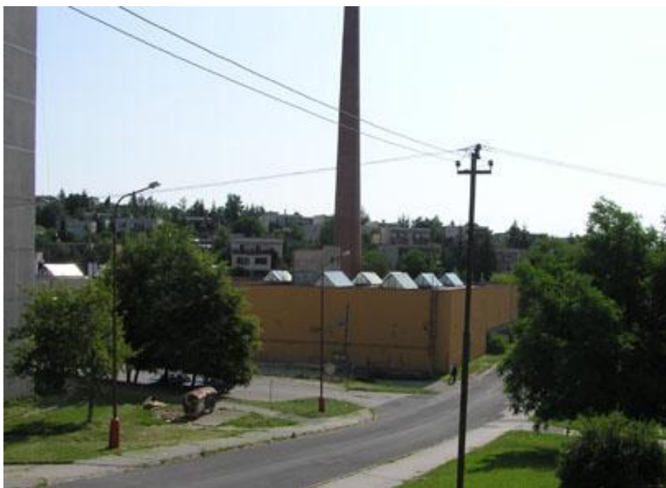
Obrázok č.6 Tepláreň na biomasu v bývalej kotolni na uhlie zdroj: www.intechenergo.sk
