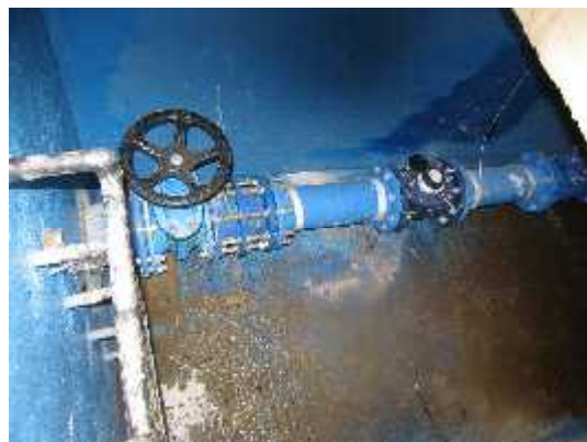
Obr. 7.2 Vodomeraná šachta
