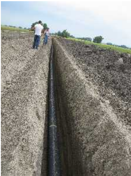
Obr. 7.7 Výkop s uloženým potrubím
