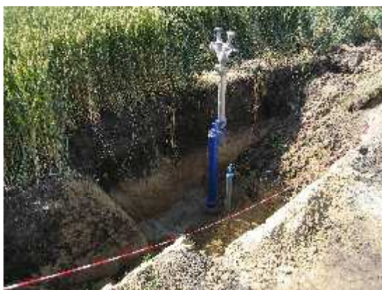
Obr. 7.5 Príprava pred tlakovou skúškou
