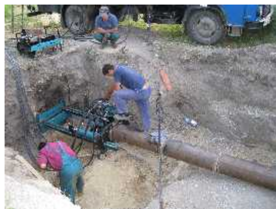
Obr. 7.4 Pretláčanie ochranného potrubia
