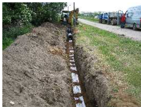
Obr. 7.6 Pokladanie výstražnej ochrannej fólie
