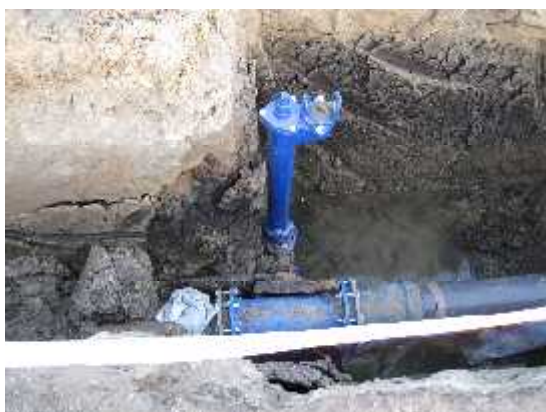
Obr. 7.3 Podzemný hydrant
