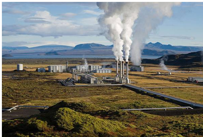
Obr. č.2 Nesjavellirská geotermálna elektrárňa na Islande
