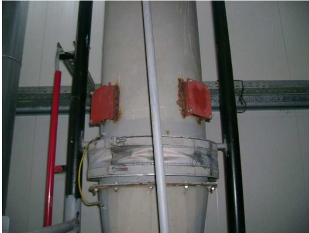
Obr. 19 Otvory na zapojenie meracích prístrojov Testo(zdroj vlastný)
