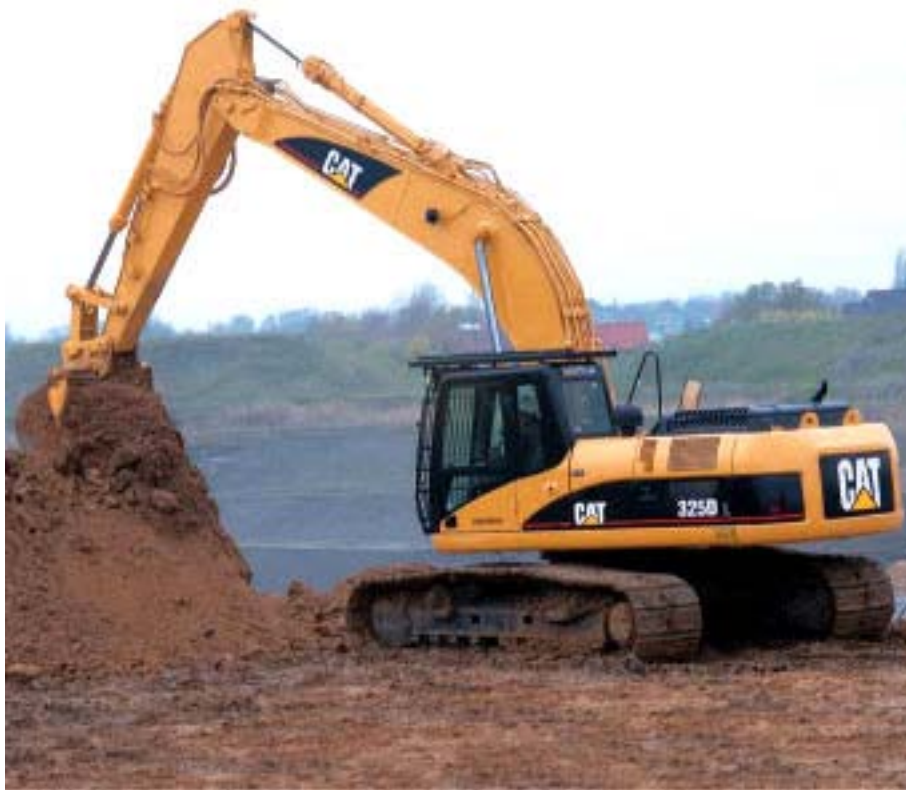
Obr. 1 Rýpadlo – CAT 325 D (23.)
